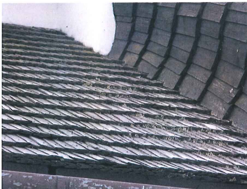
W poniższych zdjęciach widać naderwane gwoździe oraz wypadnięte gonty
