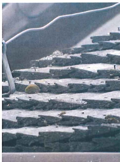
W poniższych zdjęciach widać naderwane gwoździe oraz wypadnięte gonty
