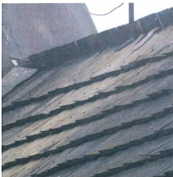
W poniższych zdjęciach widać naderwane gwoździe oraz wypadnięte gonty
