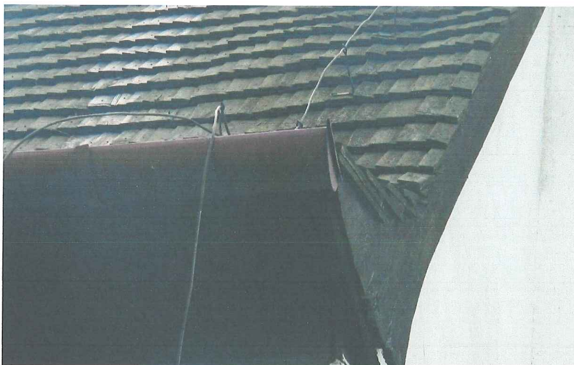
Fot42. Kępachy, kościół parafialny pw. św. Marcina. Fragmenty gontowego pokrycia dachu . Fot B. Kulka, lipiec 2022r
